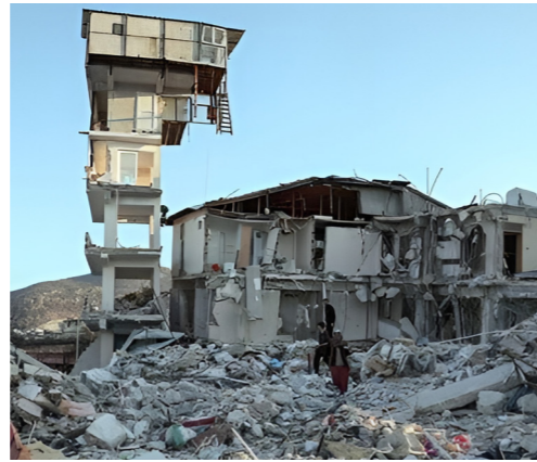
6 Şubat 2023 Hatay Depreminde Yıkılan 4 katlı binanın ayakta kalan eklentisi.
